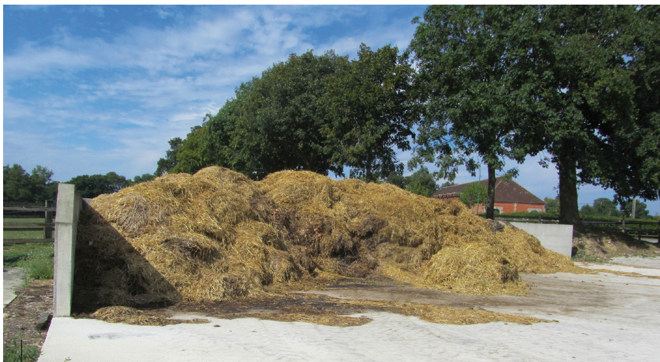
— Fumière avec fosse de récupération de jus (Jumenterie du Pin, 61)
