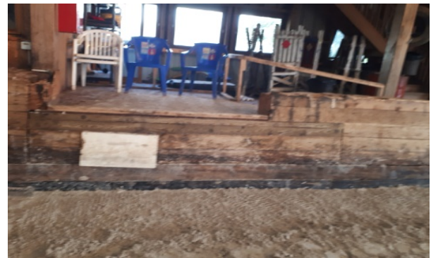
Estrade et rampe aménagée dans le manège
