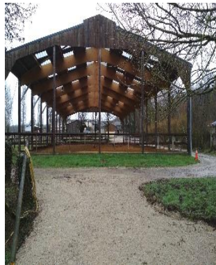
Manège construit en 2015
