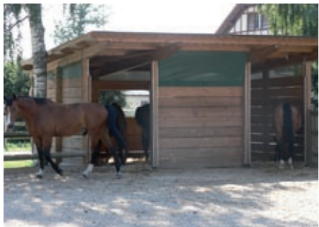
Un sol dur se justifie pour des espaces très fréquentés tels que surface d'affouragement ou de repos
